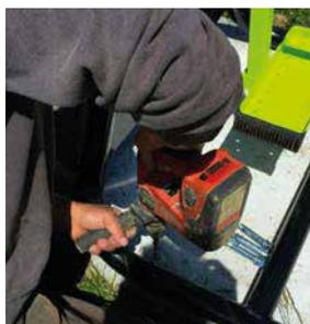
Couler une dalle de 2m20 par 1m20 par 10cm de profondeur ou 2 bandes de béton (une à gauche et une à droite de l'appareil) aux dimensions suivantes : 110cm de long, 30cm de large et 40 cm de profondeur. Percez votre dalle puis chevillez l'appareil à l'aide des chevilles fournies
