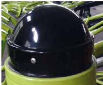
Refermer la demi sphère à l'aide de 3 rivets. Finition: Pour une finition parfaite, effectuer un joint silicone entre les parties hautes des poignées et du piètement et le pôle central afin d'éviter le ruissellement de l'eau de pluie entre le pôle et les éléments assemblés.
