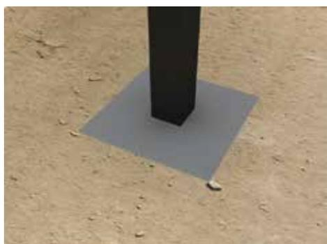
Coulez le béton dosé à 350 kilos jusqu'au niveau 0 ou -5cm pour éviter que les plots béton soient apparents.
