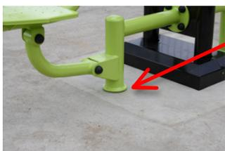
**ATTENTION:** Vérifiez que les pieds situés sous les sièges reposent parfaitement sur votre dalle béton. Si besoin, ajoutez du béton sous les pieds afin que ceux-ci reposent bien au sol (ne jamais laisser les pieds de l'appareil au dessus du niveau de la dalle).
